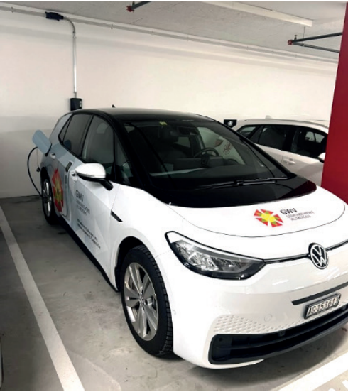
Ladeinfrastruktur in Tiefgarage, 1PP ausgebaut und 1PP vorbereitet
