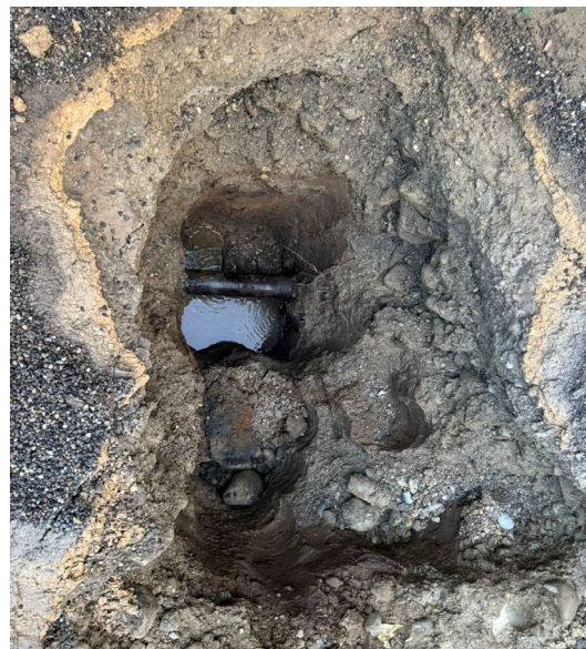
Rohrbruch Mühlemattenweg
