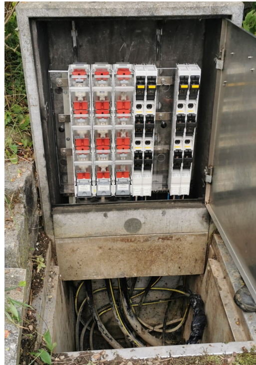
Verteilkabine nach Reparatur
