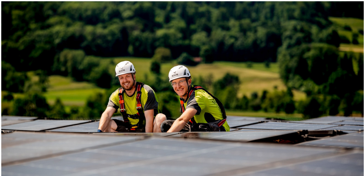
Installation einer Photovoltaikanlage
