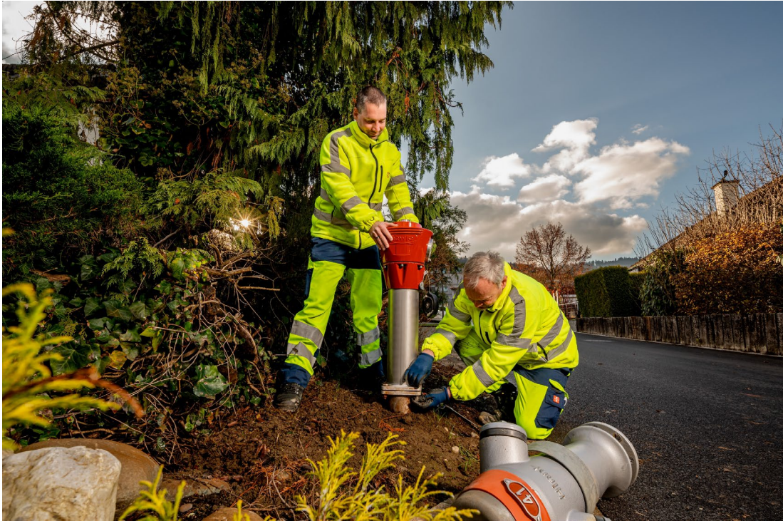
Erneuerung Hydrant, Marino Jappert und Mario Schaad
