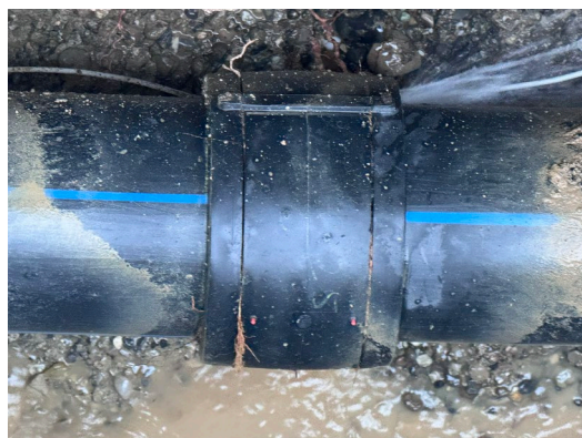
Rohrbruch Allmendstrasse
