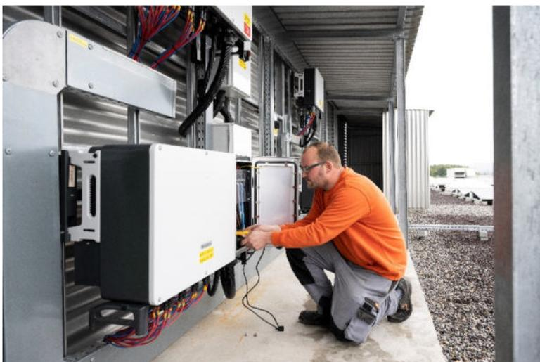
PV-Anlage GELOG II - Michael Steinhauer, Leitender Elektroinstallateur der GWV bei der Prüfung des Wechselrichters
