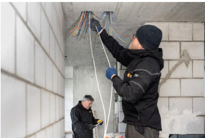
André Bleichmann, Leitender Elektroinstallateur EI (GWV) mit Alessandro Simonetta, Elektroinstallateur EI (GWV) bei Installationsarbeiten im Rohbau (Kabel- und Drahteinzug)
